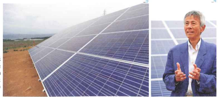
4_市民ソーラー創業者の澤光春さん 5_太陽光発電に好条件である一方、時に風速30mもの強風が吹くことも。このためパネルを支える架台は一般のものに比べ数段頑丈に
