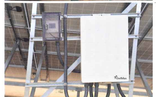
6_日本一の日照時間を誇る北杜市。夏にはそれを象徴するように60万本のひまわりが満開となり「北杜市明野サンフラワーフェス」も開催(写真協力:北杜市) 7_現在360枚のパネルからなる北杜1号、北杜2号の発電所が稼働 8_太陽光発電の心臓部となるパワーコンディショナ。自然環境に合わせて効率的に動く高性能タイプを使用 9_近隣の協力店や農場などで優待サービスも受けられるオーナー証
